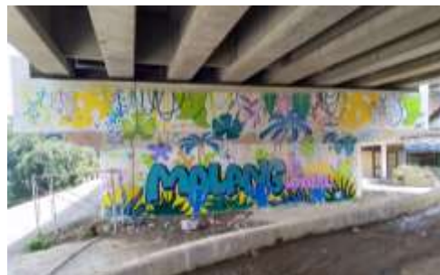
Gambar 6 Graffiti di Tembok Bawah Jembatan Kedungkandang Kota Malang
